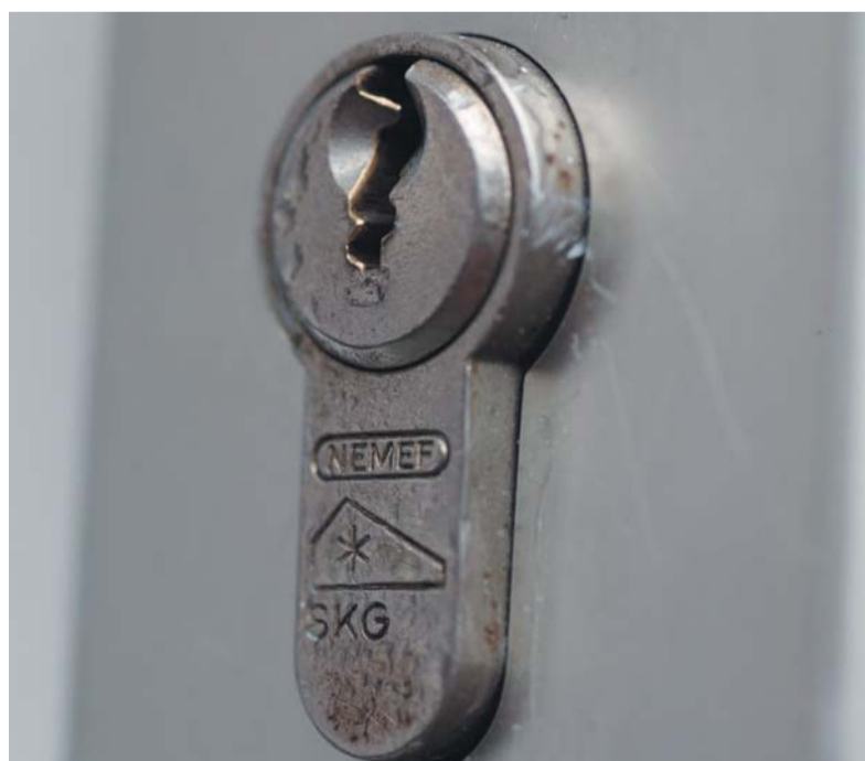
Een cilinder die uitsteekt is een eenvoudige prooi voor dieven.
