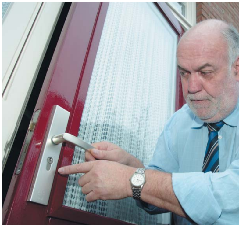
Een verzonken cilinder en niet afschroefbare deurplaat houden dieven langer buiten de deur.
